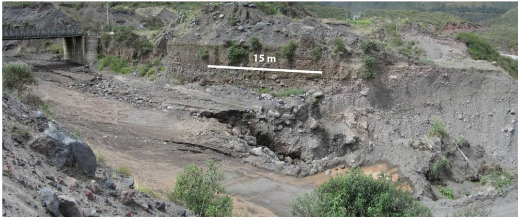
*Figura 28.. Depósito de lahar bajo los puentes Bailey. Notar el avance de la erosión regresiva (entre 10 y 15 m) en el cambio de pendiente de la quebrada.*
