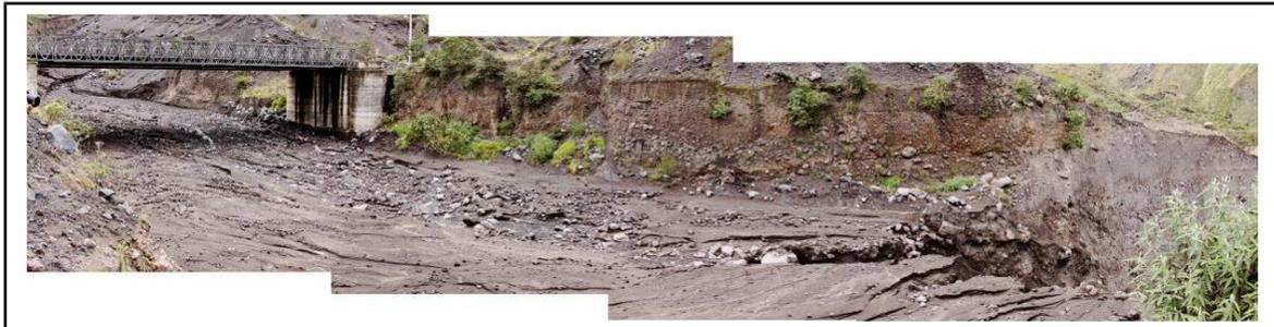
**Figura 21.** Panorámica en el sector de los puentes de La Pampa, se observa la erosión regresiva (Foto: P. Ramón-OVT/IG)
