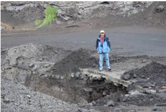
Agua lodosa en la quebrada Romero. Note la erosión de la capa de cemento. Foto: Luis Manzanillas IG/EPN
