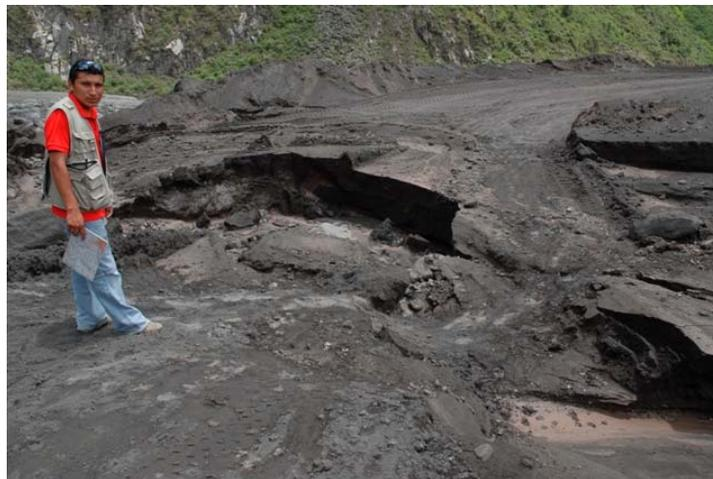
*Figura 28: Vía inhabilitada a consecuencia de grandes flujos de lodo en la Q. Romero.*
