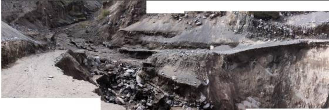
*Figura 30: Erosión del cauce de la Q. Achupashal y colapso de la mesa de la carretera en ambas márgenes por efecto de los últimos lahares.*
