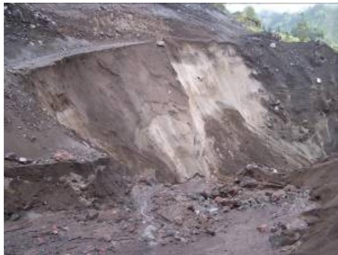
**Figura 18.** Lahar en la quebrada de Mandur, destrucción de la vía a Penipe del margen izquierdo de la quebrada. Se observa pequeños deslizamientos debido a un alto contenido de humedad. El lahar acarreó bloques de 50 cm
