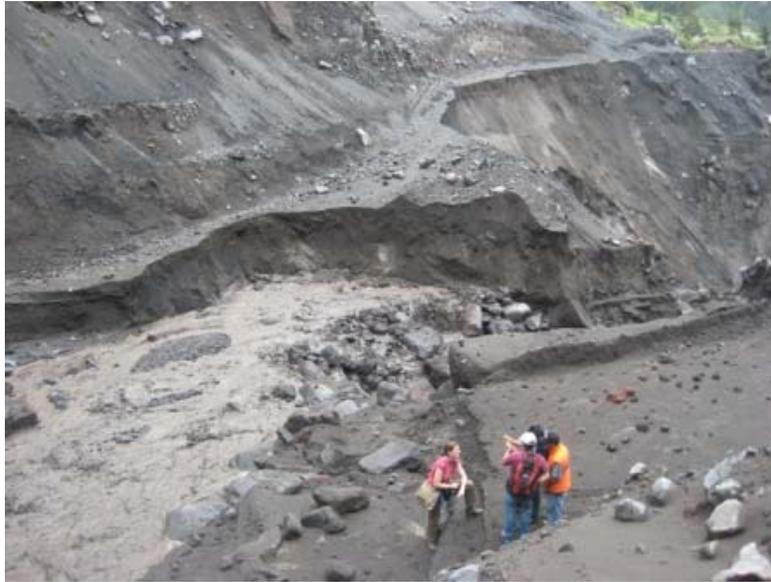
*Figura 23: Socavamiento del relleno y destrucción del paso de la quebrada Achupashal debido a los lahares del 05 al 07 de Abril.*
