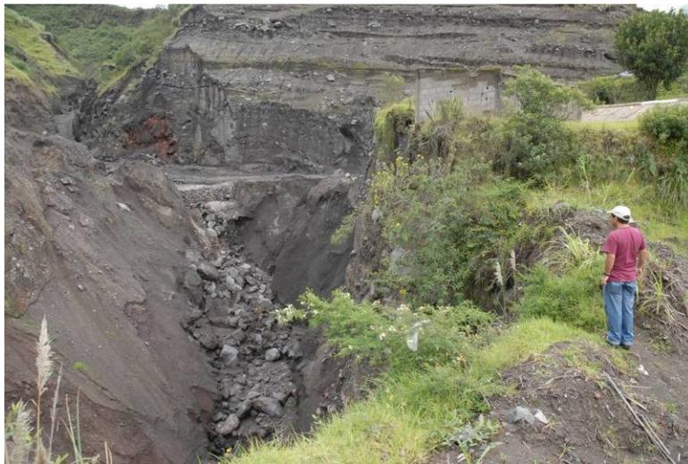
*Figura 24: Socavamiento del cauce de la quebrada Bilbao. Atrás se observa el paso que se encuentra junto al lecho del río. Esta parte está reforzada con gaviones para disminuir la erosión regresiva.*
