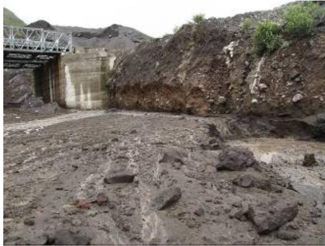
**Foto 10:** Lahar en la Pampa. El estribo de la margen derecha es erosionado por el flujo de lodo.
