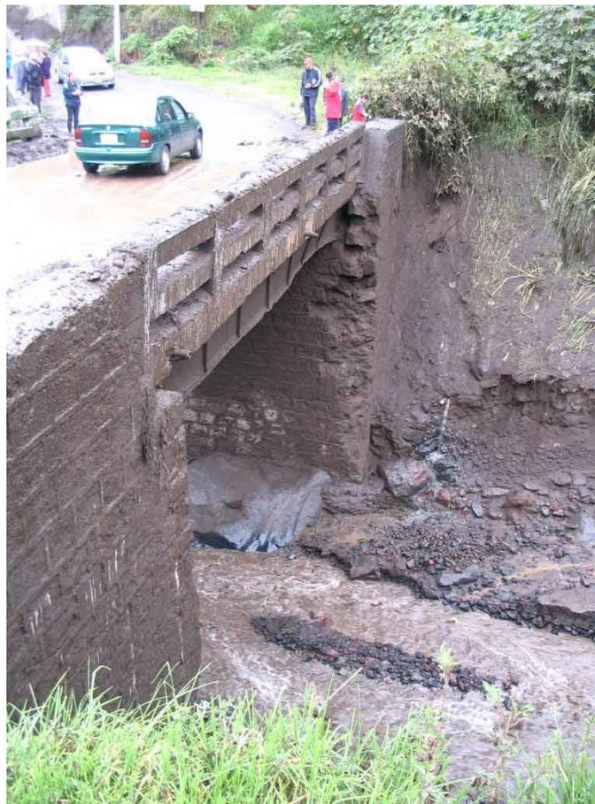
**Fig. 12d** El flujo transitó sobre el puente viejo del Vascún dejando un depósito de 20 cm de lodo sobre este. La viga horizontal del puente se encuentra doblada.
