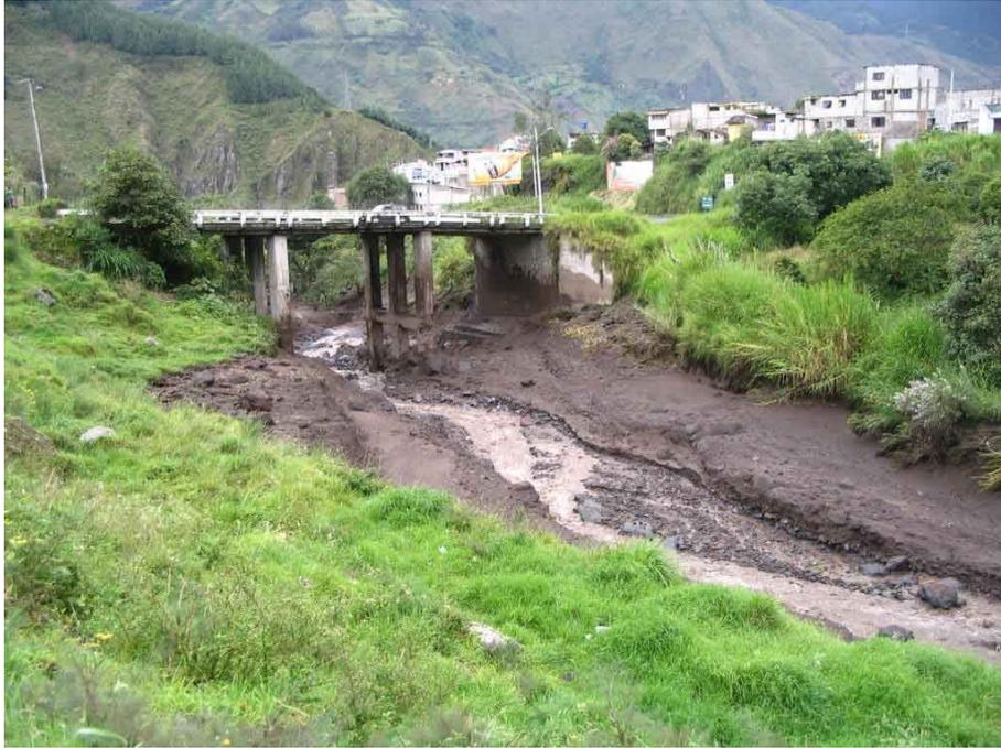
Fig. 12e Depósito del aluvión en el sector del puente principal de ingreso a Baños. El pilar central fue dañado por las rocas.
