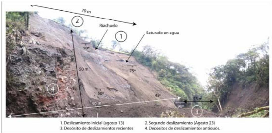
Fig. 12a Deslizamiento en el sector de Nahuazo. Fotografía tomada el 25 de Agosto del 2008 (D. Barba).
